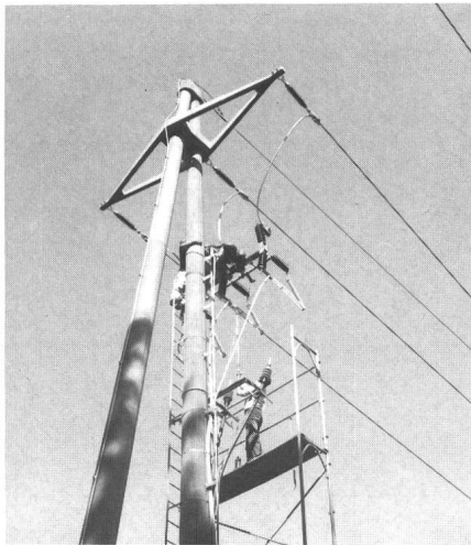
Fig. 3 Arbeitsgerüst vor dem Betonmast für die Montage des Kabelendverschlusses
