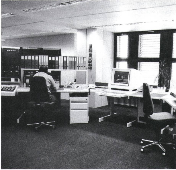
Fig. 2 Überwachungszentrale mit Arbeitsplätzen für Gebäude- und Netzleitsystem
