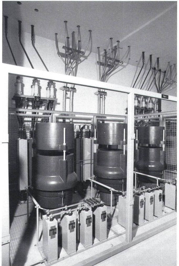
Fig. 6 Parallelankopplung 16 kV, 25 MVA
