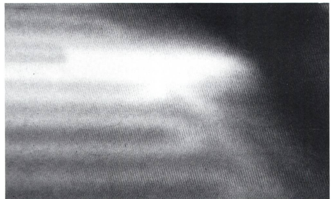
Figur 9 Thermographie- Aufnahme zeigt Leckstelle in Fussbodenheizung
