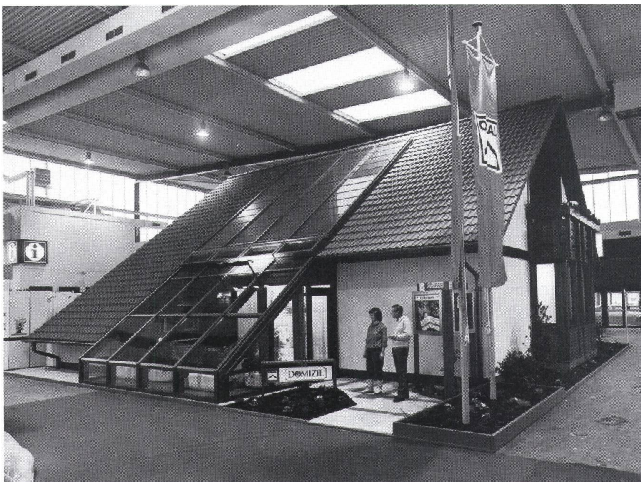
Figur 1 Einfamilien-Musterhaus der Firmen AEG und Okal mit 30 m 2 Solarzellen. Der Solargenerator besteht aus 48 Modulen und liefert bei optimalen Verhältnissen eine elektrische Leistung von 2 kW.
