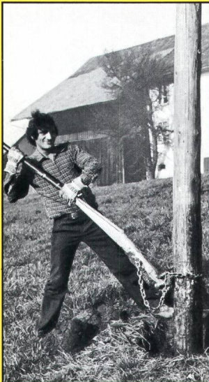
Nachimprägnierung von Holzmasten
