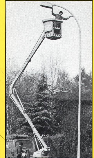
Korrosionsschutz an Stahlkandelabern
