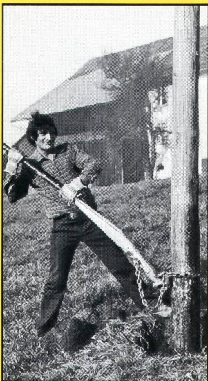
Nachimprägnierung von Holzmasten
