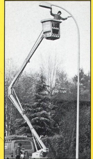
Korrosionsschutz an Stahlkandelabern
