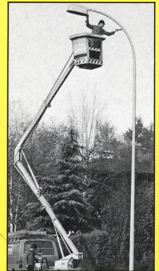
Korrosionsschutz an Stahlkandelabern
