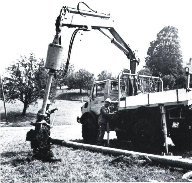
Figur 1 (oben links) und 2 (unten links) Bohrer beim sogenannten Ausheben des Mastloches. Das Fahrzeug Unimog ist mit Abstützvorrichtung an 4 Punkten abgestützt. Für den vorgesehenen 13-m-Holzmast wird ein Loch mit einem Durchmesser von 0,55 m auf eine Tiefe von 1,80 m ausgehoben.
