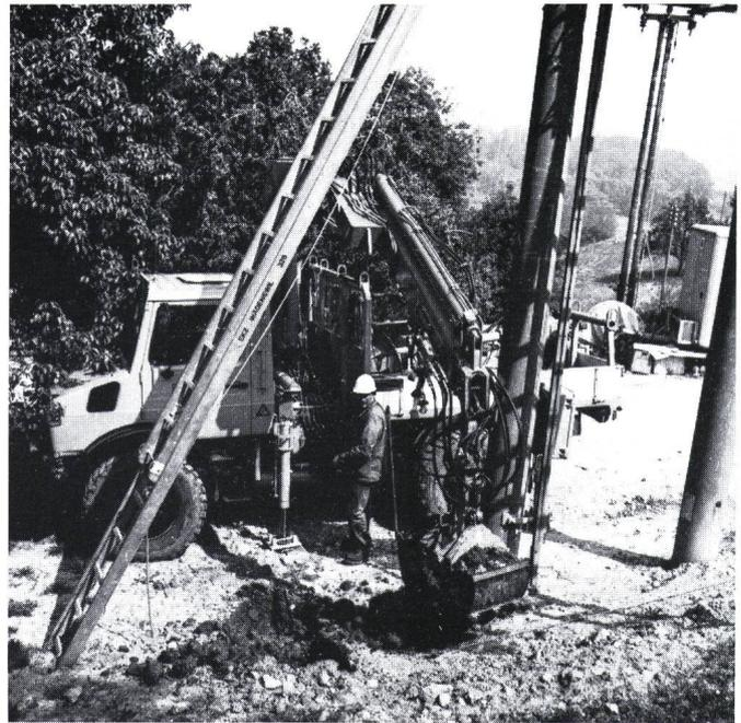
Figur 5 Arbeit mit Greifer (Sonderausrüstung)
