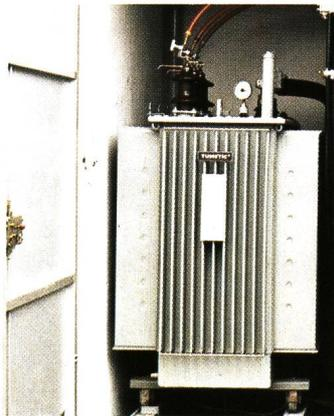
Bei Platzmangel, schwer zugänglichen Standorten und erhöhten Anforderungen an die Wartungsfreiheit ersetzt ein hermetisch geschlossener, elastischer Faltschalenkessel das Expansionsgefäß:
