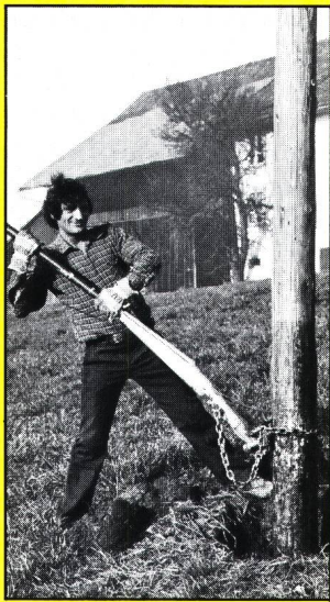
Nachimprägnierung von Holzmasten
