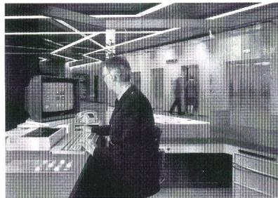
Das Bild zeigt eine mikroprozessorgesteuerte Gruppe von Schindler-Aufzügen. Am Bildschirm werden das Fahrverhalten kontrolliert, Parameter verändert, Fehler erkannt sowie Statistiken erstellt.
