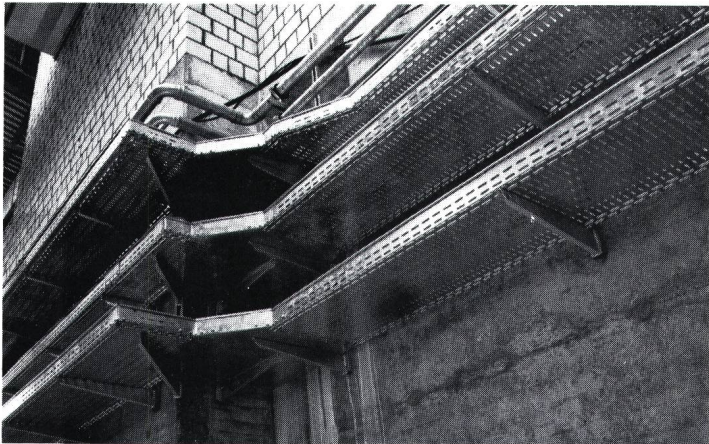
Metallbahnen, Gitterbahnen Kunststoffbahnen mit schockgeprüftem Trägermaterial für Zivilschutzbauten
