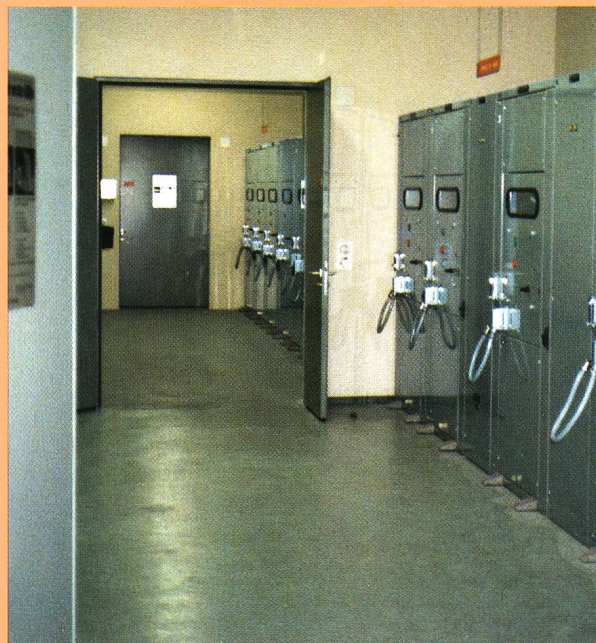
Fig. gauche: Armoire avec 3 contacteurs à vide 6 kV en couplage Dahlander, pour la ventilation
