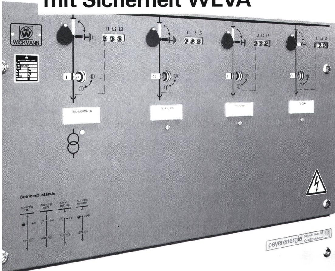
WEVA-Mittelspannungs-Schaltanlage heisst: höchste Verfi barkeit, Personenschutz, wafungsfrei, bescheidener Platz darf, problemlose Fernsteue flexible Planung von 2 bis 6 der, einphasige Metallkaps Vakuumschaltelemente, Tr schutz über Vakuumschalte schalter mit Wandler-Schut lais-Kombination und-und-1
