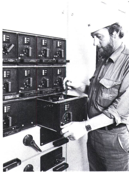
Figur 1 Personensichere Einstellarbeiten an einer modularen Niederspannungsschaltanlage (Einschubtechnik)
