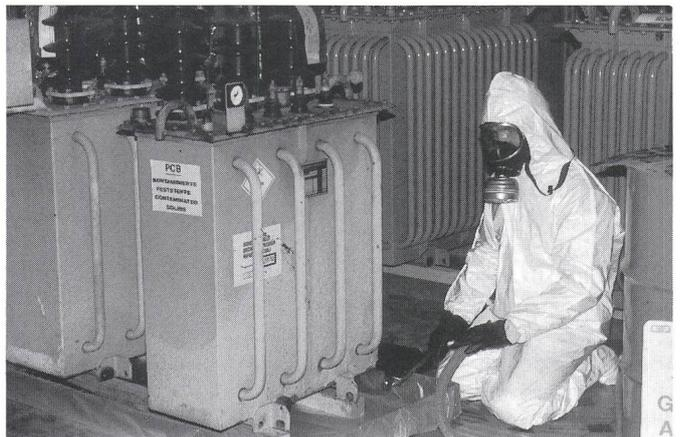
Figur 4 Zum Abpumpen bereitgestellte Trafos mit PCB-verseuchtem Isolieröl
