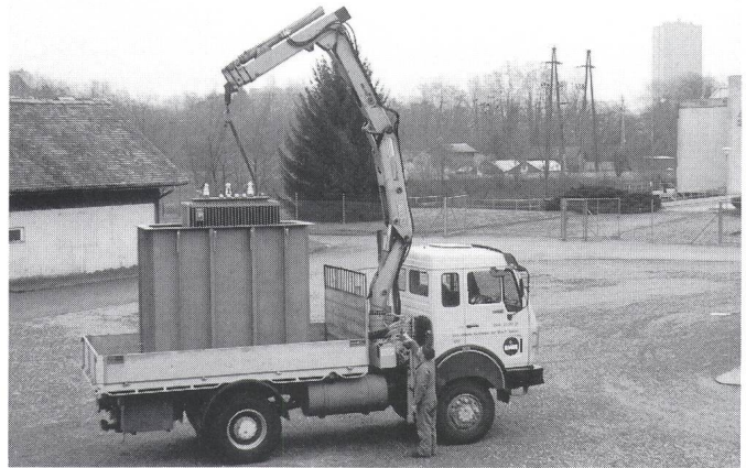
Figur 2 Strassentransport eines PCB-Transformators in einer Spezialwanne
