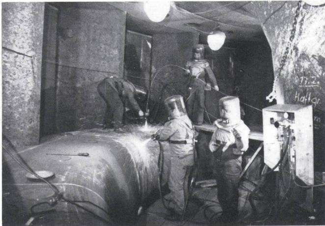
**Figur 2 Panzerung durch Materialauftrag am Leitradring einer Kaplan-turbine der Staufufe Braunau Simbach in Österreich.**
