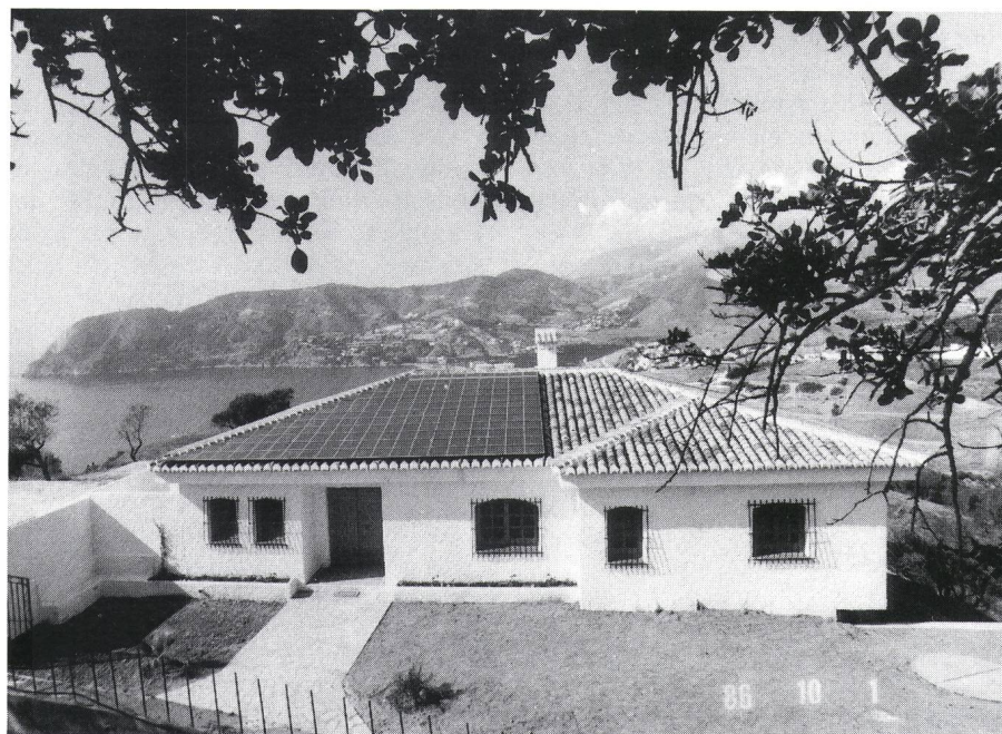
Figur 1 Ein typisches Haus an Spaniens Südküste. Trotz der Verwendung der dort üblichen Rundziegel wirkt der von First bis Traufe durchgehende PV-Generator nicht als Fremdkörper. Auch dieser Generator ist auf das Ziegeldach aufgesetzt.
