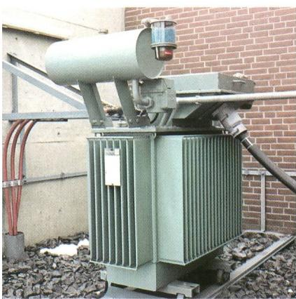
Das ist Verteiltrafo-Standard. Weltweit zehntausendfach bewährte Öltrasfos in verschiedenen Ausführungs- und Anschlussvarianten. Leistungsbereich 50 bis 2500 kVA:
