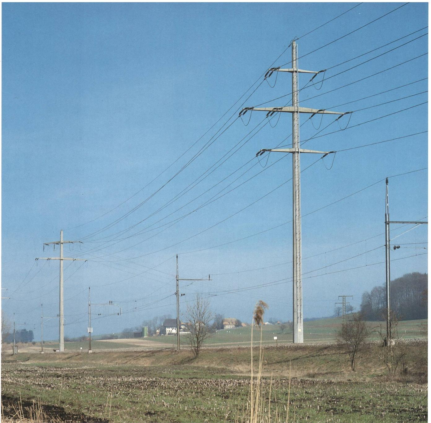
L'illustration ci-dessus présente un des nombreux mâts Gram en béton armé et précontraint livrés dans le cadre de la réalisation de l'important projet de la ligne de transport de 132 kV des Chemins de fer fédéraux suisses qui relie **Kerzers à Bienne**.
