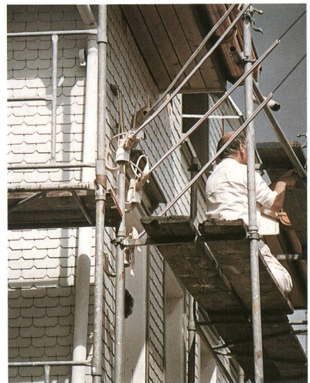
Figur 8 Malerlehrling schlüpfte durch provisorisch isolierte Frontanschlussdrähte
