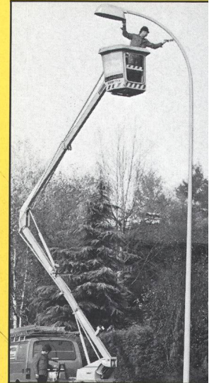
Korrosionsschutz an Stahlkandelabern
