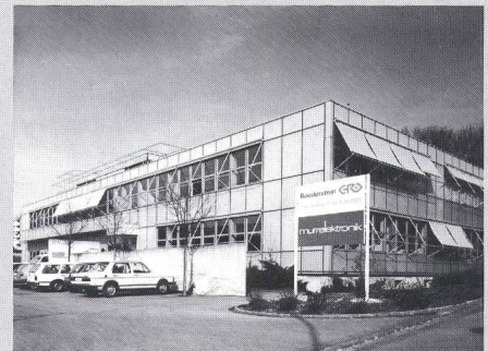
Büro- und Lagergebäude der Roederstein – Schweiz
