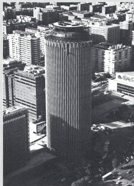
30stöckige Torre Europa in Madrid mit Klimaanlage von Sulzer
