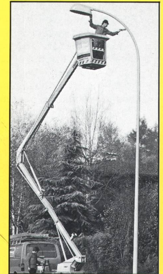
Korrosionsschutz an Stahlkandelabern
