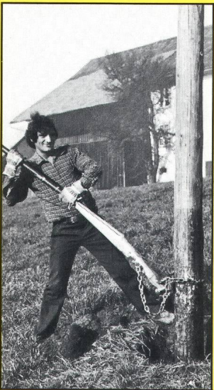
Nachimprägnierung von Holzmasten
