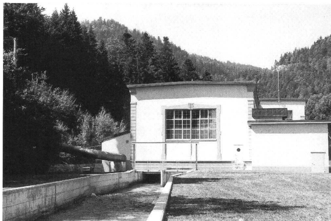
Centrale de La Dernier. Au premier plan, le canal de fuite.
