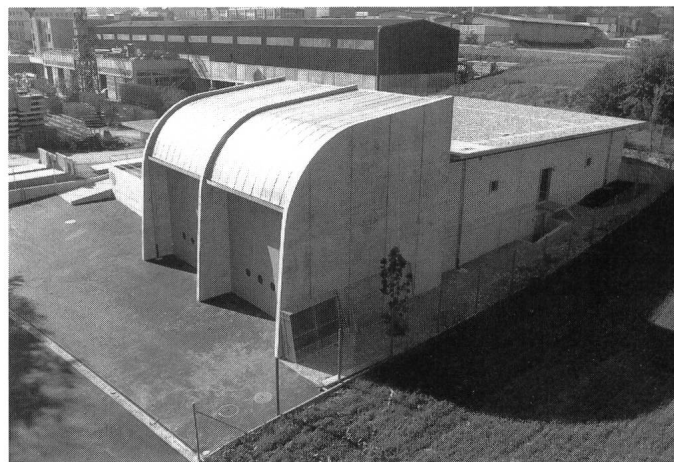
Betriebsgebäude mit eingebauten Traforäumen (Nordansicht)
