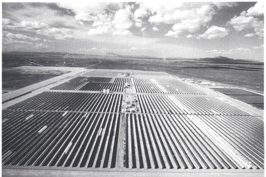
Bild 3 Parabolrinnen-Solarkraftwerk der Firma Luz in Kalifornien
