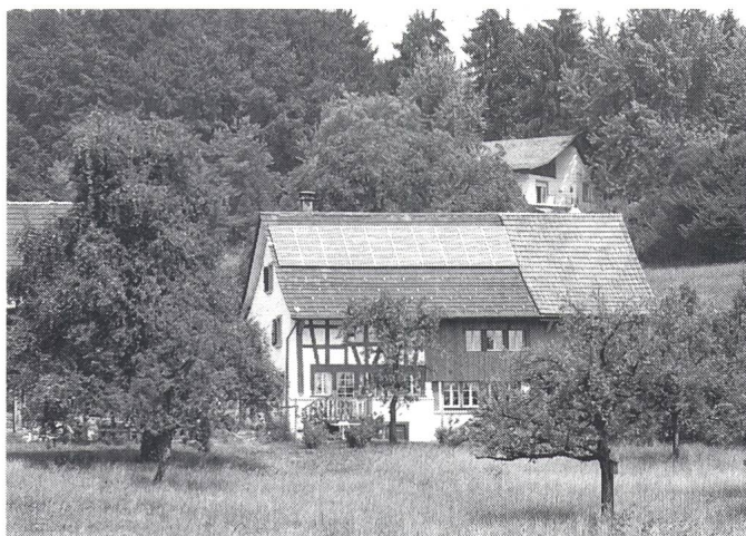
Eine 3-kW-Solaranlage aus dem Projekt Megawatt
