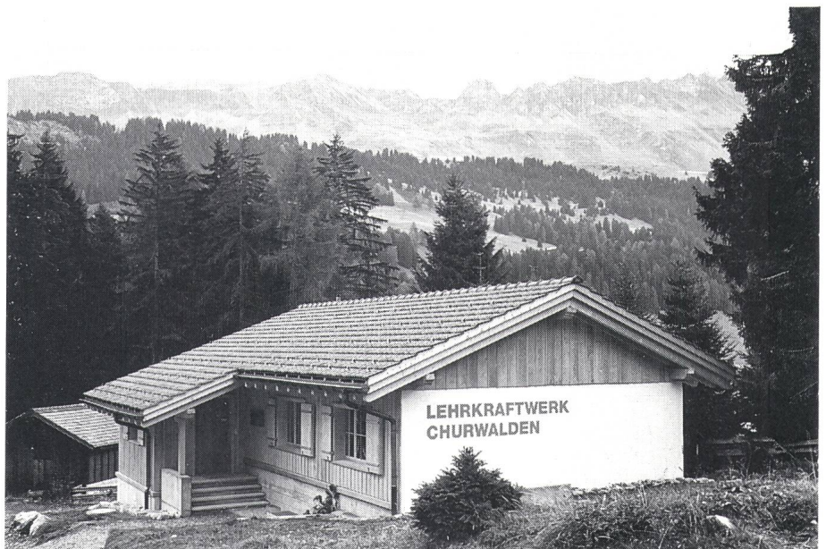
Bild 1 Das heimelige Holzgebäude des Demonstrationskraftwerkes in malerischer Umgebung
