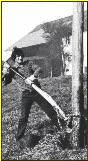
Nachimprägnierung von Holzmasten
