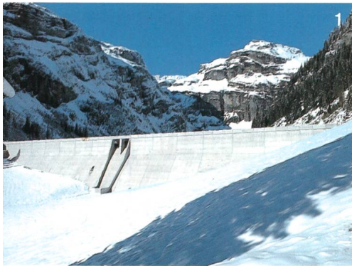
1 Die Staumauer des Panixersees der Kraftwerke Ilanz (Graubünden) konnte 1990 vollendet werden. Ab 1992 wird sie 7,2 Mio. Kubikmeter Wasser zurückhalten.
