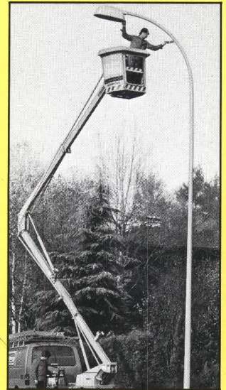
Korrosionsschutz an Stahlkandelabern
