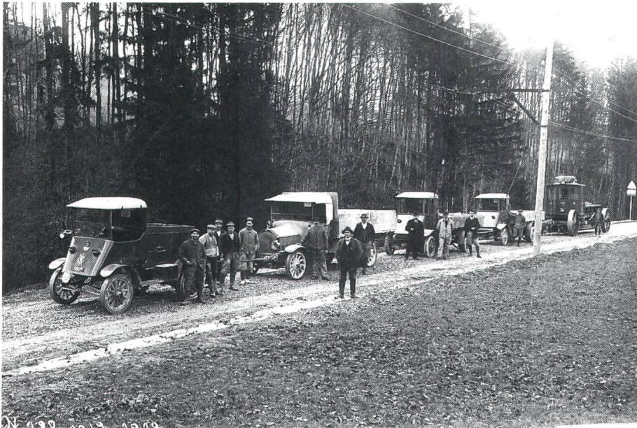
Die «geleislose Bahn» beim Bau des Wasserkraftwerkes mit einem Batterie-Traktor
