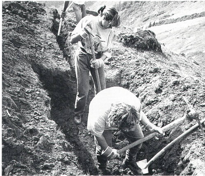
Lehrtöchter und Lehrlinge beim Bau des Kleinkraftwerks im Berner Oberland. In mühsamer Handarbeit mussten Gräben zur Verlegung von Stromkabeln geöffnet werden
