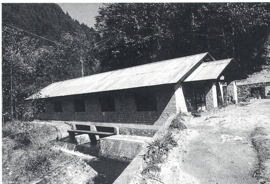
Bild 1 Das Kraftwerk im Tal des Solu Khola. Zurzeit ist erst eine Maschineneinheit mit einer installierten Leistung von 180 kW in Betrieb
