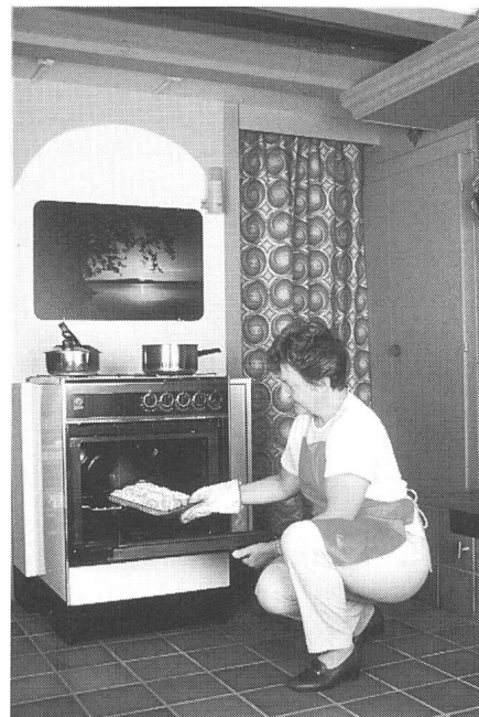
Bild 4 Frau Friedli vor dem wasserstoff-beheizten Kochherd. Sensoren verschiedener Empfindlichkeit melden allfällige Leckagen: Die erste Stufe spricht schon bei einem Prozent Wasserstoff in der Luft, also weit unter der «Knallgas-Konzentration» von 18%, an. Ihr Signal löst über Blinklichter und Glocke Alarm aus und verriegelt automatisch die Wasserstoff-Hauptleitung
