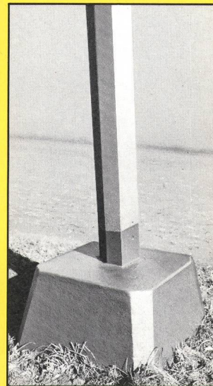
Betonschutz an Mastsockeln
