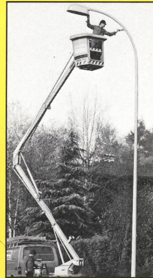
Korrosionsschutz an Stahlkandelabern
