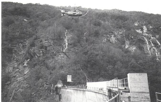
**Bild: Abliegung eines der 35 L-förmigen Elemente (4,3 Tonnen) auf der Krone der Staumauer Vasasca**
