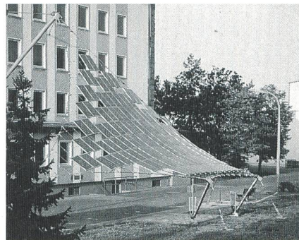
Bild 6 Seilnetzaufständiger für Standard-Solarmodule
