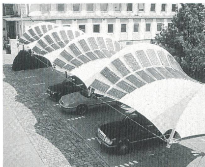
Bild 4 Parkplatzüberdachung mit applizierten Standardmodulen
