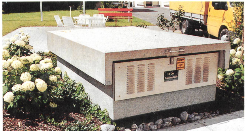
Fertig-Transformatorstation, Typ: Unterflur C
