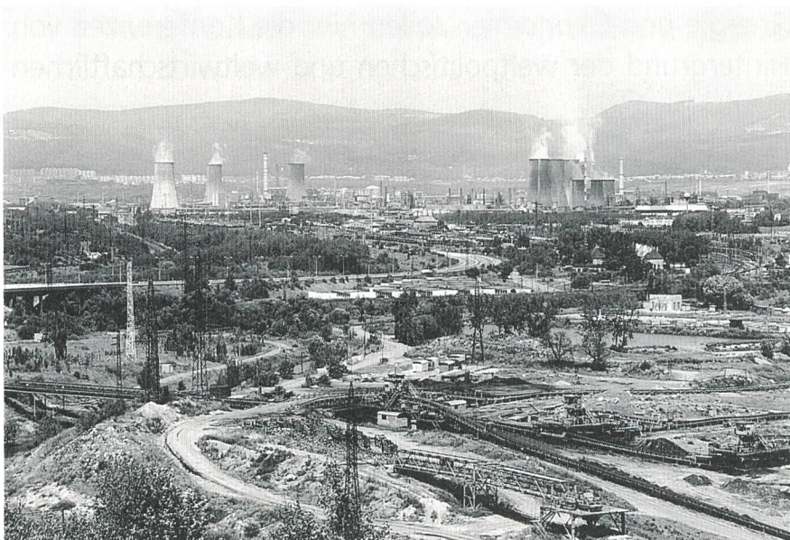
Bild 2 Kohlekraftwerk in einem Land des ehemaligen Ostblocks
