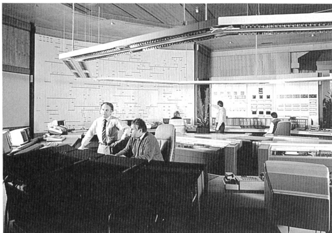
Im Lastregler (Dispatching) der EGL wird die Einhaltung der vereinbarten Austauschprogramme der Schweiz mit dem Ausland überwacht
