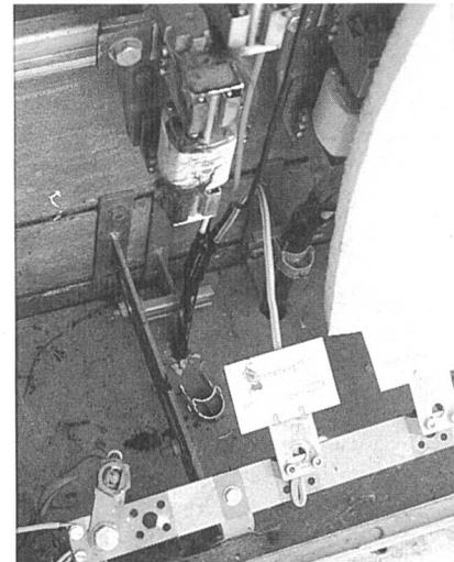
Ungenügende Abdeckung spannungsführender Teile beim Arbeiten in einer Verteilkabine
