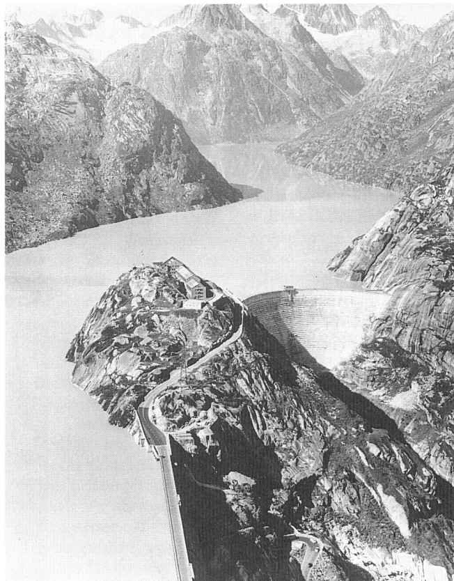
Wasserkraftanlagen 1992: hohe Funktionstüchtigkeit. Hier Stausee Grimsel
