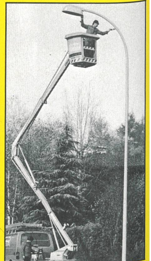
Korrosionsschutz an Stahlkandelabern
