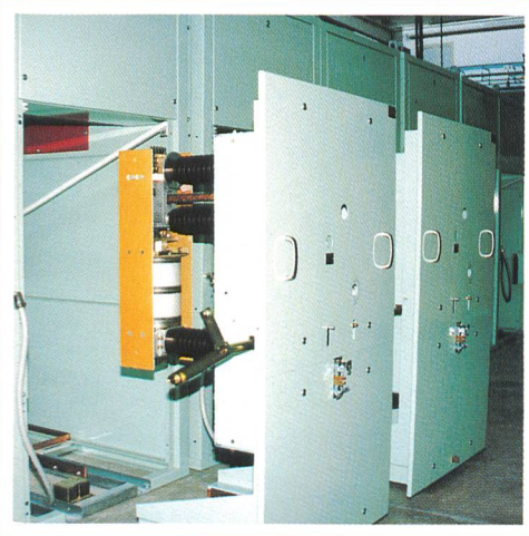
Cellules interrupteurs et cellules disjoncteurs Vakuum-Last- und -Leistungsschalterzellen für SBB/UW Eglisau
