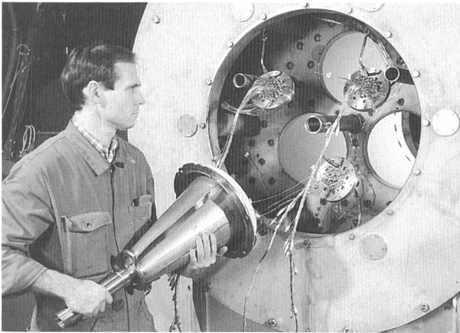
Montage d'un brûleur BV du système pilote 10 MW de ABB
