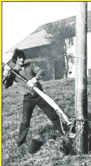
Nachimprägnierung von Holzmasten
