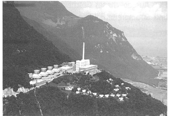
Depuis 1980, Chavalon fonctionne comme centrale de réserve
