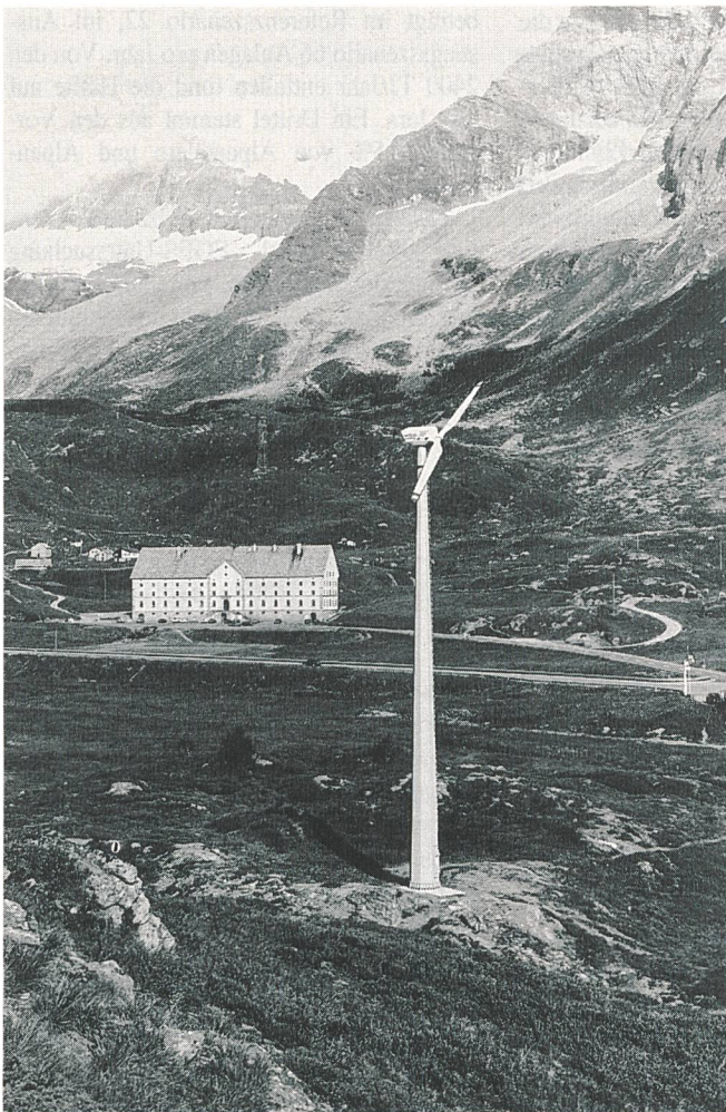
Bild 2 30-kW-Windkraftanlage auf dem Simplon (Foto: Alteno AG)
