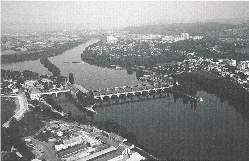
Bild 2 Ohne äusserlich ersichtliche Veränderungen (hier vor dem Umbau) sowie ohne negative Einflüsse auf die Umwelt wird das Rheinkraftwerk Augst-Wyhlen zurzeit modernisiert
